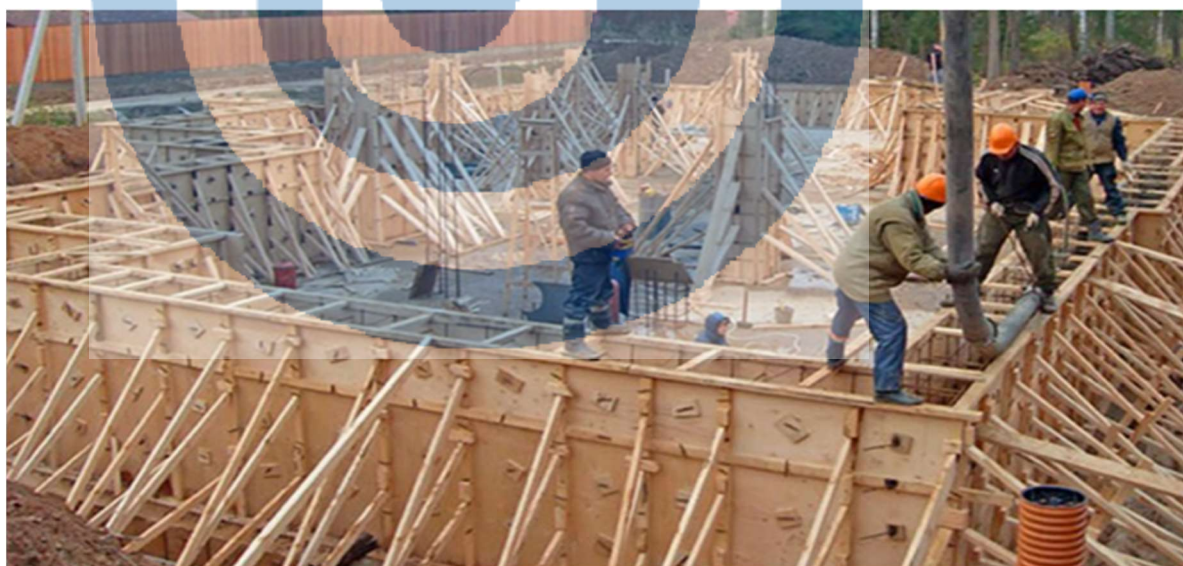
3.2 Сурет – Қалыптарға жүктемелердің әсер ету үлгісі [17]
